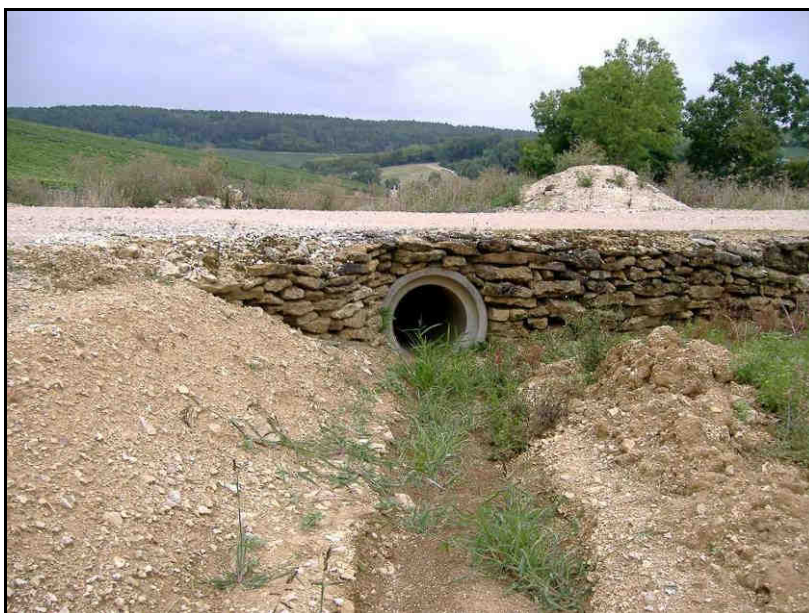
Photo 3 : exutoire de type fossé busé, à Beine
